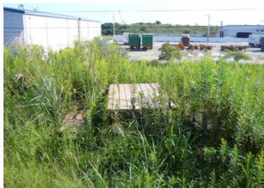
図9 新港北側遊歩道の一部
