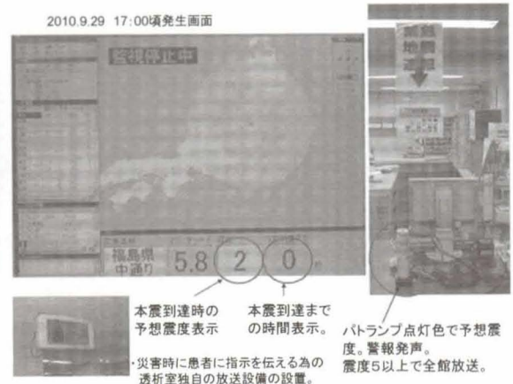
写真6. 緊急地震速報システムの導入と透析室独自の放送システムの設置
